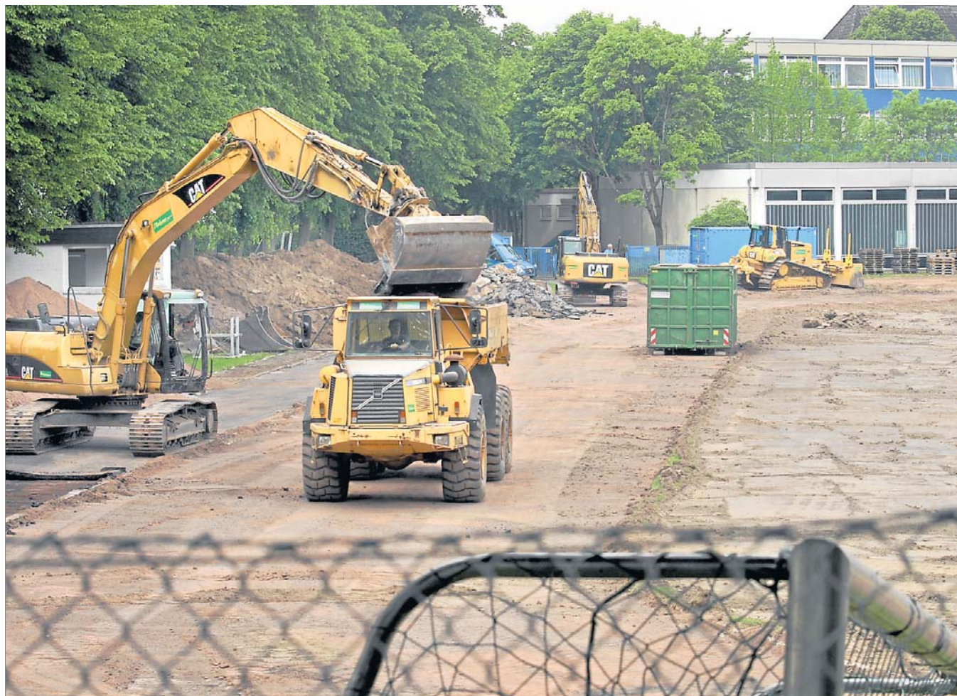
Inzwischen ist vom alten Herderstadion kaum noch etwas zu erkennen. Die Baufirma hat den Rasen und die Aschenpackung der Rundlaufbahnen abgefräst, um den Baugrund für die neuen Beläge zu schaffen. Im September soll die Anlage fertig sein. ■ Foto: Hennes
